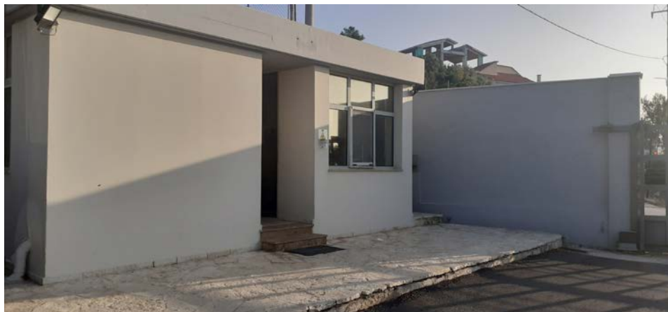
Εικόνα 1: Φωτογραφία Νότιας Όψης Θυρωρείου _ Φυλακίου
