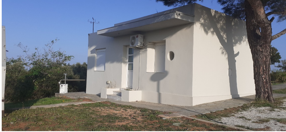
Εικόνα 10 Φωτογραφία Ανατολικής και Νότιας όψης του κτηρίου του Σελοστάτη. Νότια είσοδος.
