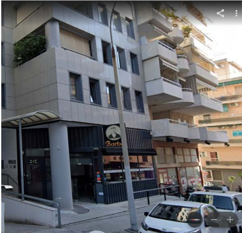
Εικόνα 13 Είσοδος Γραφείων επί της οδού Καρύστου 6
