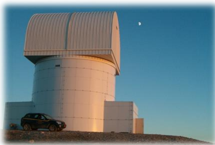
Το κτήριο του θόλου στο Αστεροσκοπείο Χελμού που στεγάζει το τηλεσκόπιο «ΑΡΙΣΤΑΡΧΟΣ».
