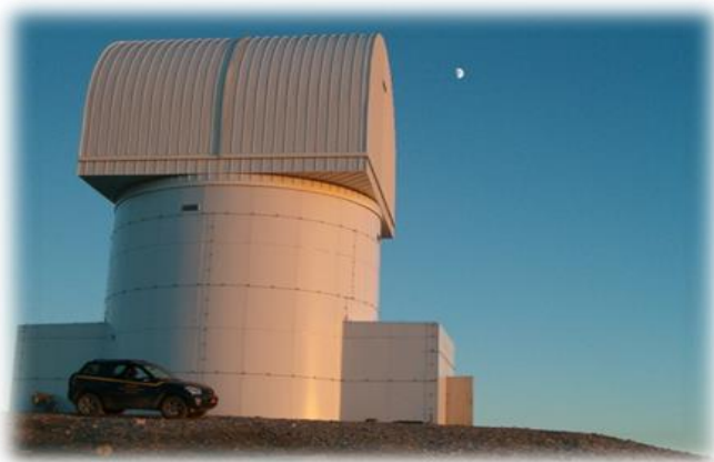
κτήριο του θόλου στο Αστεροσκοπείο Χελμού που στεγάζει το τηλεσκόπιο «ΑΡΙΣΤΑΡΧΟΣ».
